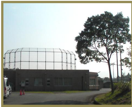
受付場所は、 スポーツセンター管理棟。
